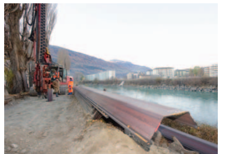
Les palplanches en métal permettront d'éviter la rupture. HOFMANN
