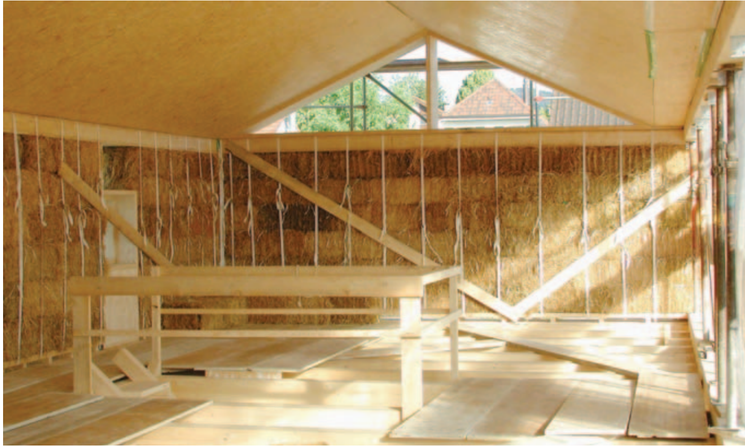
La construction de Nax sera édifée selon le même principe que cette maison en Suisse. Les bottes de pailles viendront d'Allemagne. Le couple n'a pas pu s'en procurer en Valais. WERNER SCHMID
